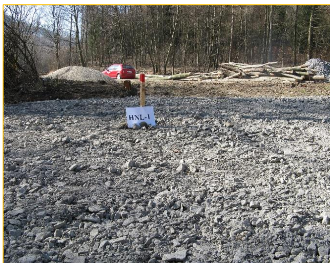
Určení míst průzkumného hydrogeologického vrtu HNL-1 na lokalitě Nová Lhota
