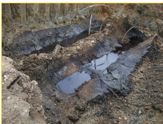
Volná fáze ropných látek v úložišti po vyzvednutí podzemních nádrží
