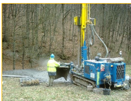
Probíhající vrtné práce na průzkumném hydrogeologickém vrtu HNL-4 na lokalitě Nová Lhota (vrtná souprava HVS-245)
