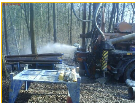
Probíhající vrtné práce na průzkumném hydrogeologickém vrtu HVS-1 na lokalitě Suchov – naražení přítoku podzemní vody
