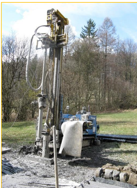
Probíhající vrtné práce na průzkumném hydrogeologickém vrtu HNL-4 na lokalitě Nová Lhota (vrtná souprava HVS-245)
