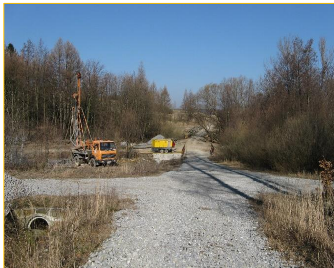
Usazování vrtné soupravy Wirth B1A na místě průzkumného hydrogeologického vrtu HNL-2 na lokalitě Nová Lhota
