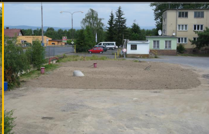
Prostor bývalé ČS PHM po závozu sanačního výkopu v úložišti
