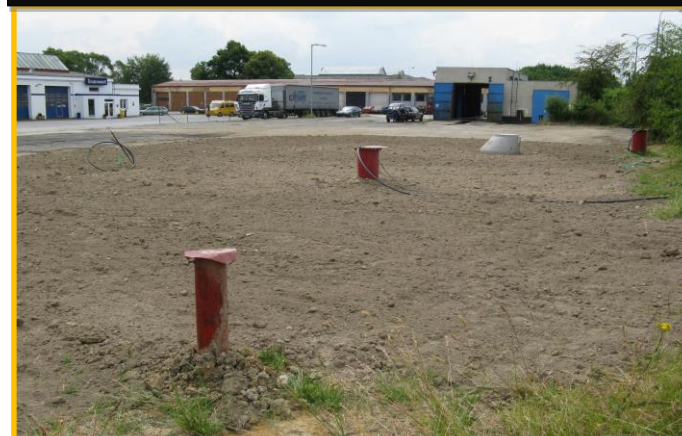
Prostor bývalé ČS PHM po závozu sanačního výkopu v úložišti
