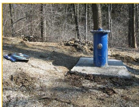
Tlakové zhlaví na průzkumném hydrogeologickém vrtu HVS-1 na lokalitě Suchov
