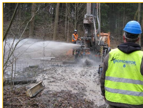
Pozitivní výtlačná úroveň na průzkumném hydrogeologickém vrtu HVS-3 na lokalitě Suchov
