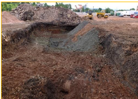
Sanační odtěžba se soustředila na ohnisko kontaminace (vysoce kontaminované jíly byly šedé na rozdíl od přirozené červené barvy permských sedimentů)
