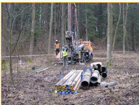
Usazování vrtné soupravy Wirth B1A na místě průzkumného hydrogeologického vrtu HVS-3 na lokalitě Suchov
