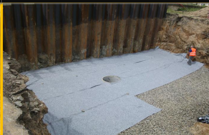
Zhotovení kameninového lože a objektu S-1 v úložišti
