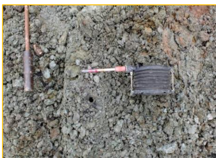
Bezprostřední monitoring kontaminace látkami C10-C40 a BTEX pomocí detekčních trubíc
