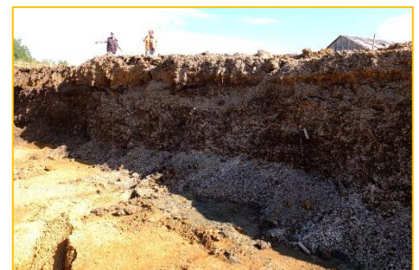
Sanační odtěžba nové skládky tvořené odpady z výroby zářivek
