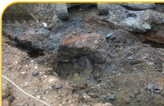
Demolice železobetonových patek nádrží v úložišti
