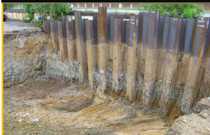
Úložiště podzemních nádrží po ukončení odtěžby
