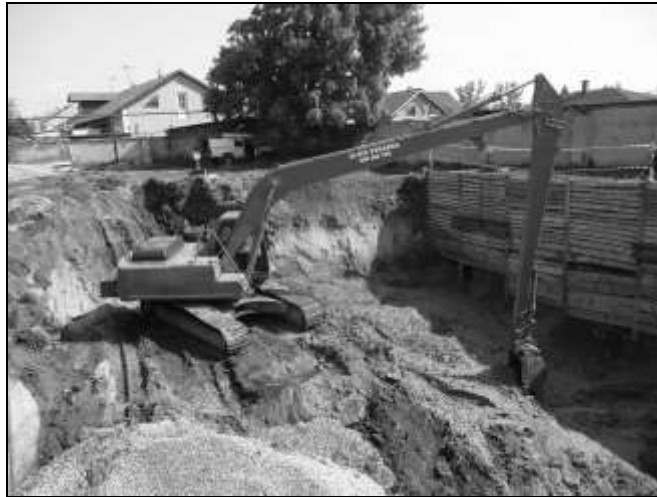
Obrázek 1: Odtěžba kontaminovaných zemin z ohniska znečištění
