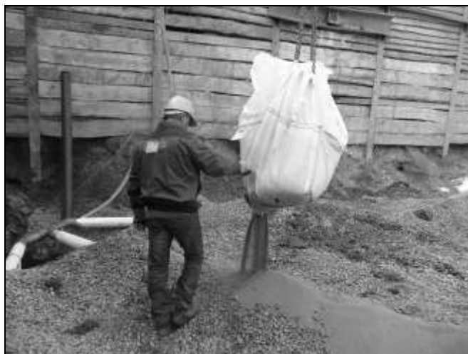
Obrázek 2: Aplikace mikroželeza na dno sanačního výkopu
