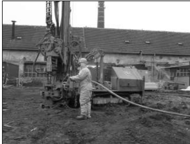
Obrázek 3: Instalace sanačních vrtů
