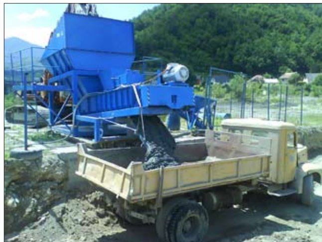
Obr. 12: Provozní zkouška solidifikace
