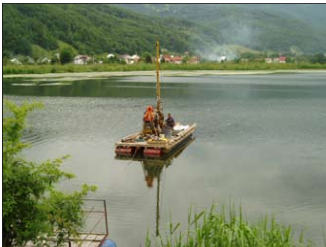
Obr. 9: Ponton s vrtnou soupravou při budování vrtů pro ověření podloží skládky
