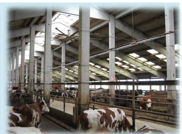
Železobetonová nosná konstrukce s vnitřními sloupy
