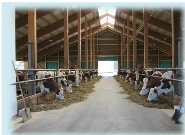
Dřevěná nosná konstrukce s vnitřními sloupy
