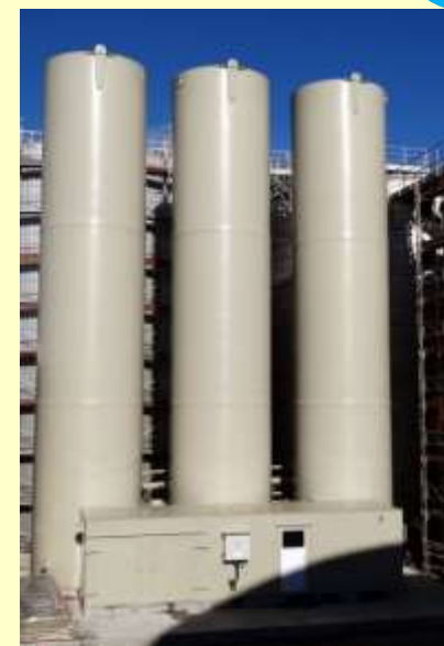
Odsiřovací jednotka – papírna - Norsko
