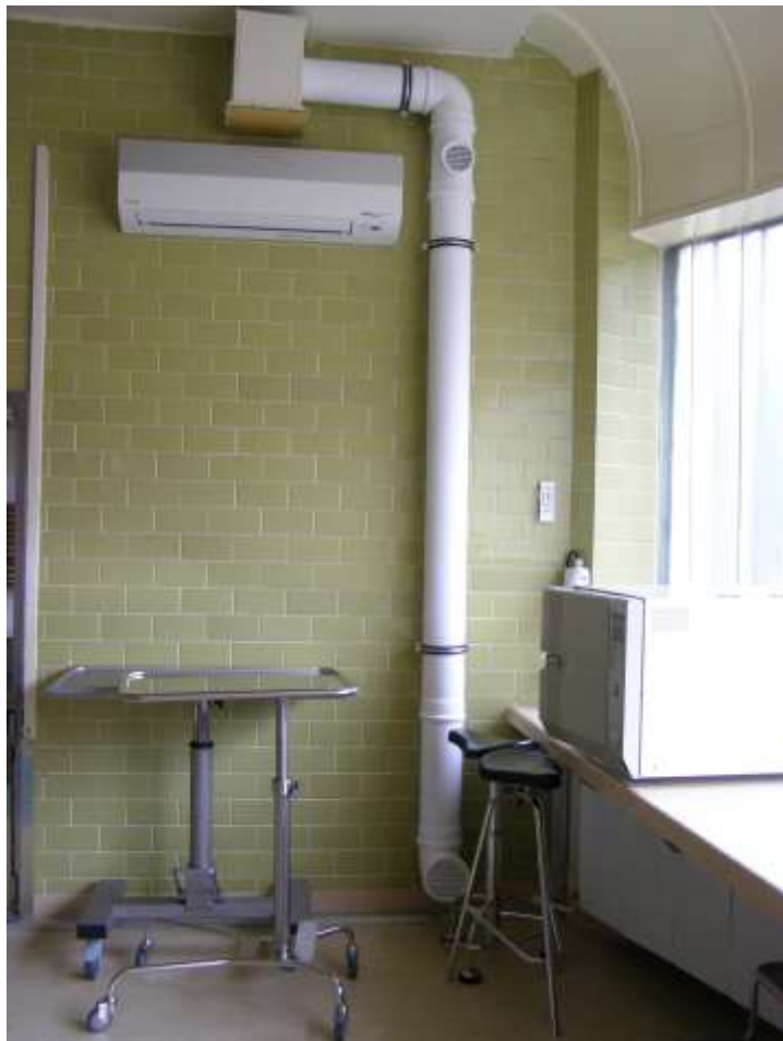
odvod vzduchu a umístění KJ
