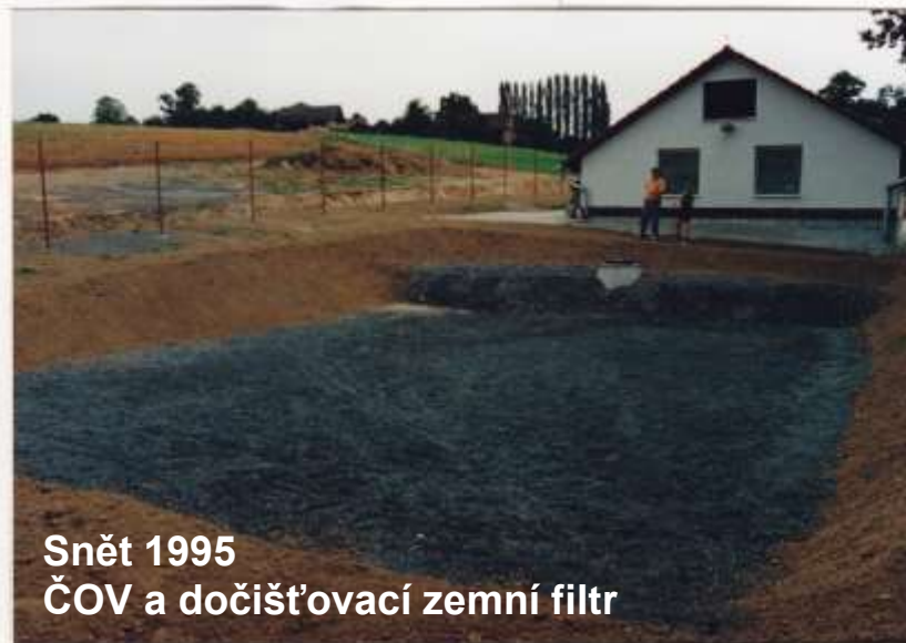
Fot.42. ČOV Snět - dočišťovací zemní filtr
