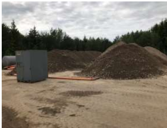
Obr. 3 Systém „biopile“
