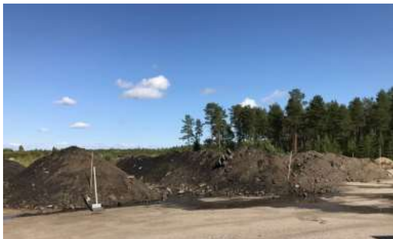
Obr. 6 Kontaminovaná zemina v průběhu biodegradace na haldách
