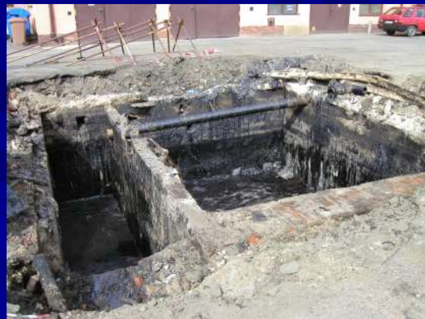
Západočeská plynárenská - lokalita Cheb Sanační práce 2002 - vyprázdněná dehtová jímka
