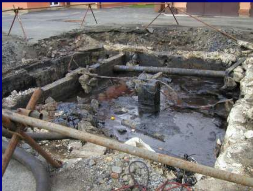
Západočeská plynárenská - lokalita Cheb Sanační práce 2002 - odkrytá dehtová jímka s původní výplní
