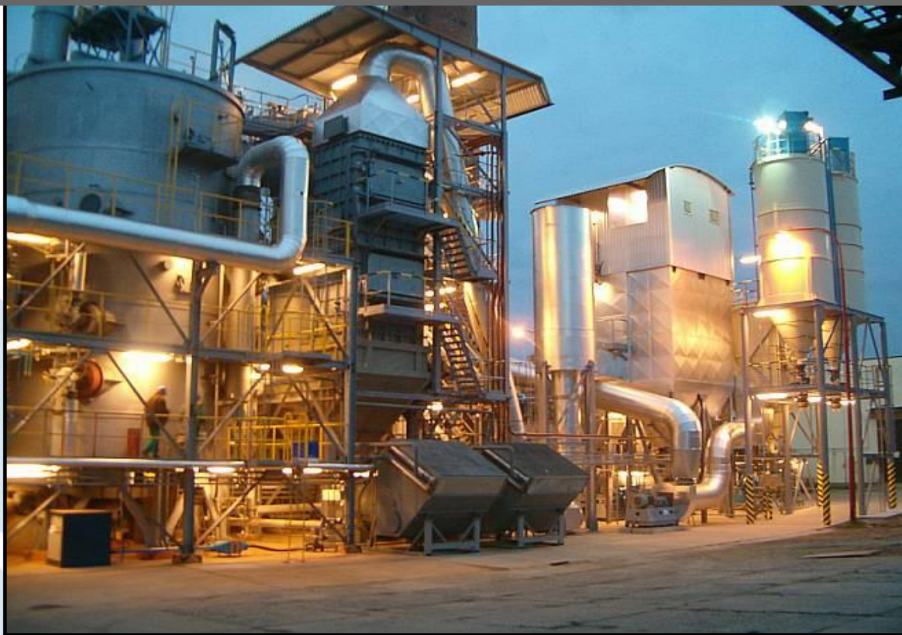
Spalovna průmyslových kalů s etážovou pecí MOL Group- Slovnaft, a.s. Bratislava
