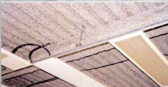
Obr. 1/V – nástřik azbestu – LIMPET
