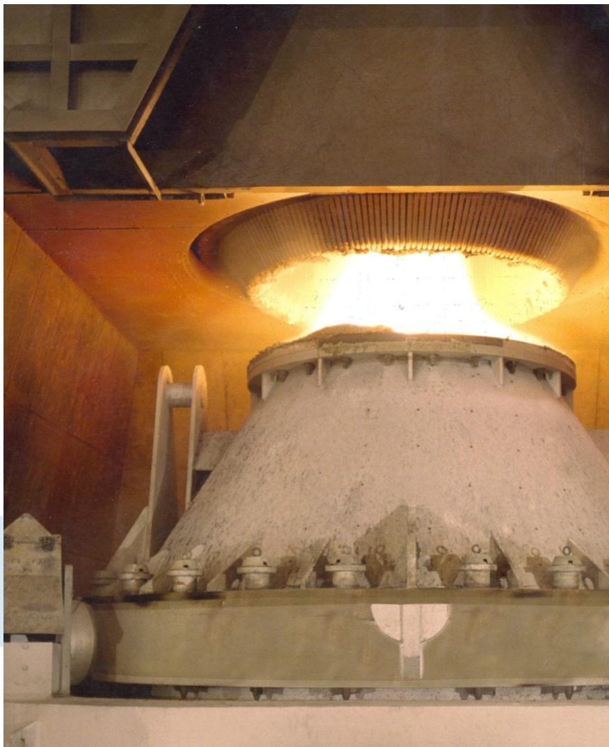
Jímání konvertorového plynu
