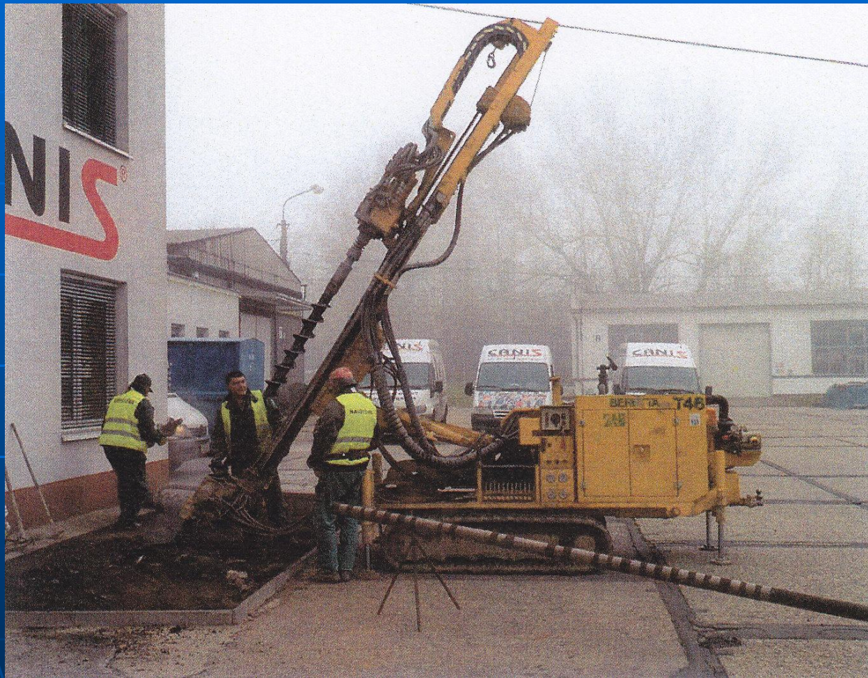
Instalace injektážních sondy
