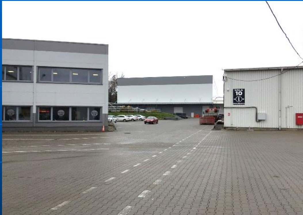
Obr. č. 7 Nový skladovací objekt
