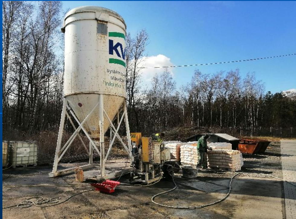
Obr. č. 5 Injektážní komplex
