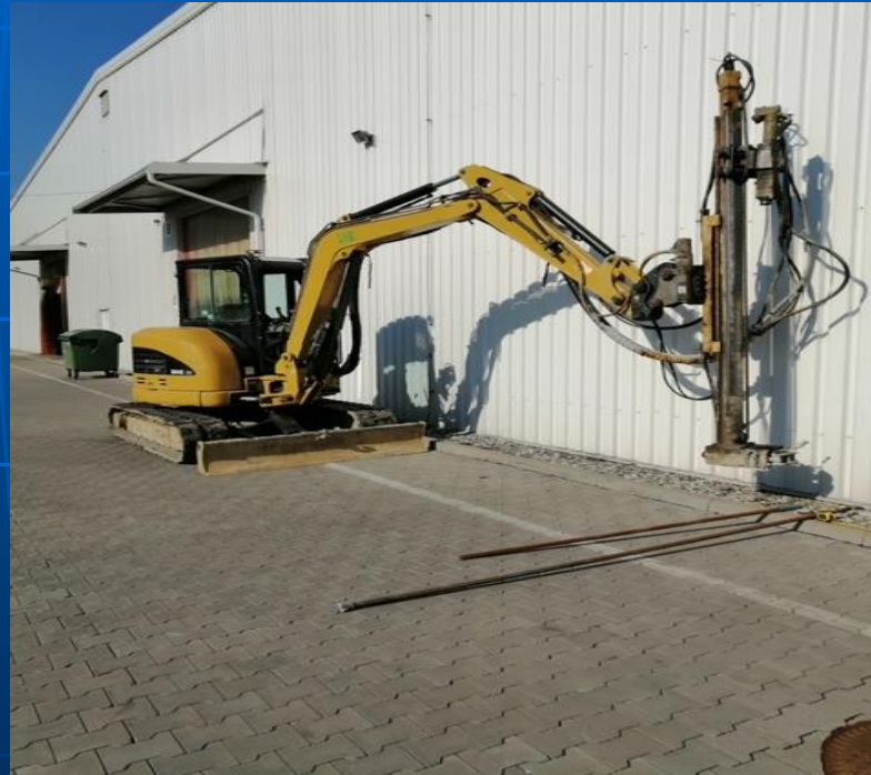
Obr. č. 4 Vrtání injektážní sondy
