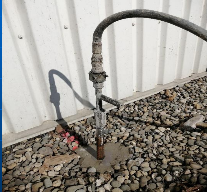
Obr. č. 2 Pohled na injektážní sondu
