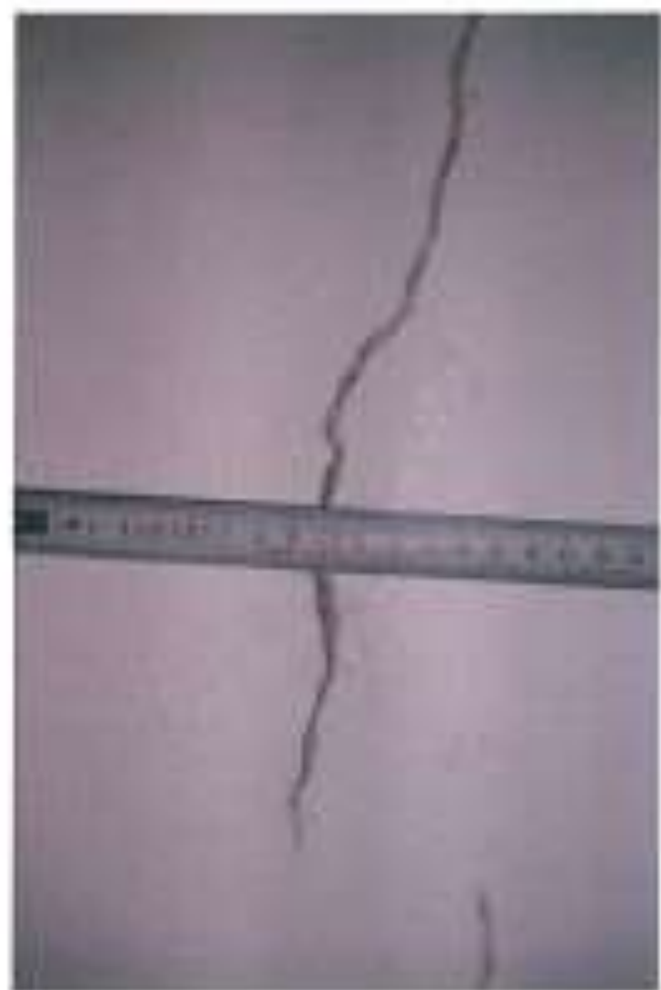
Popraskané zdivo i nástavec bývá důsledek vyhoření sazí
