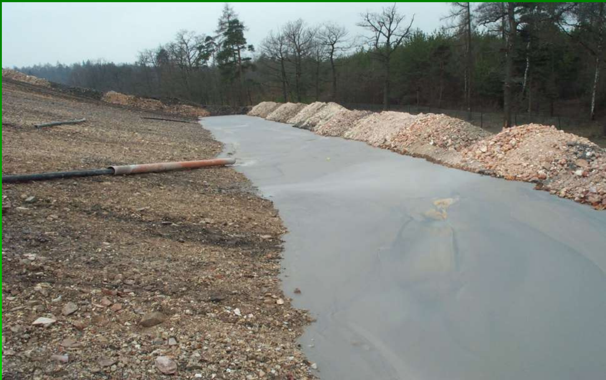
Plavení izolační vrstvy na svazích odvalu
