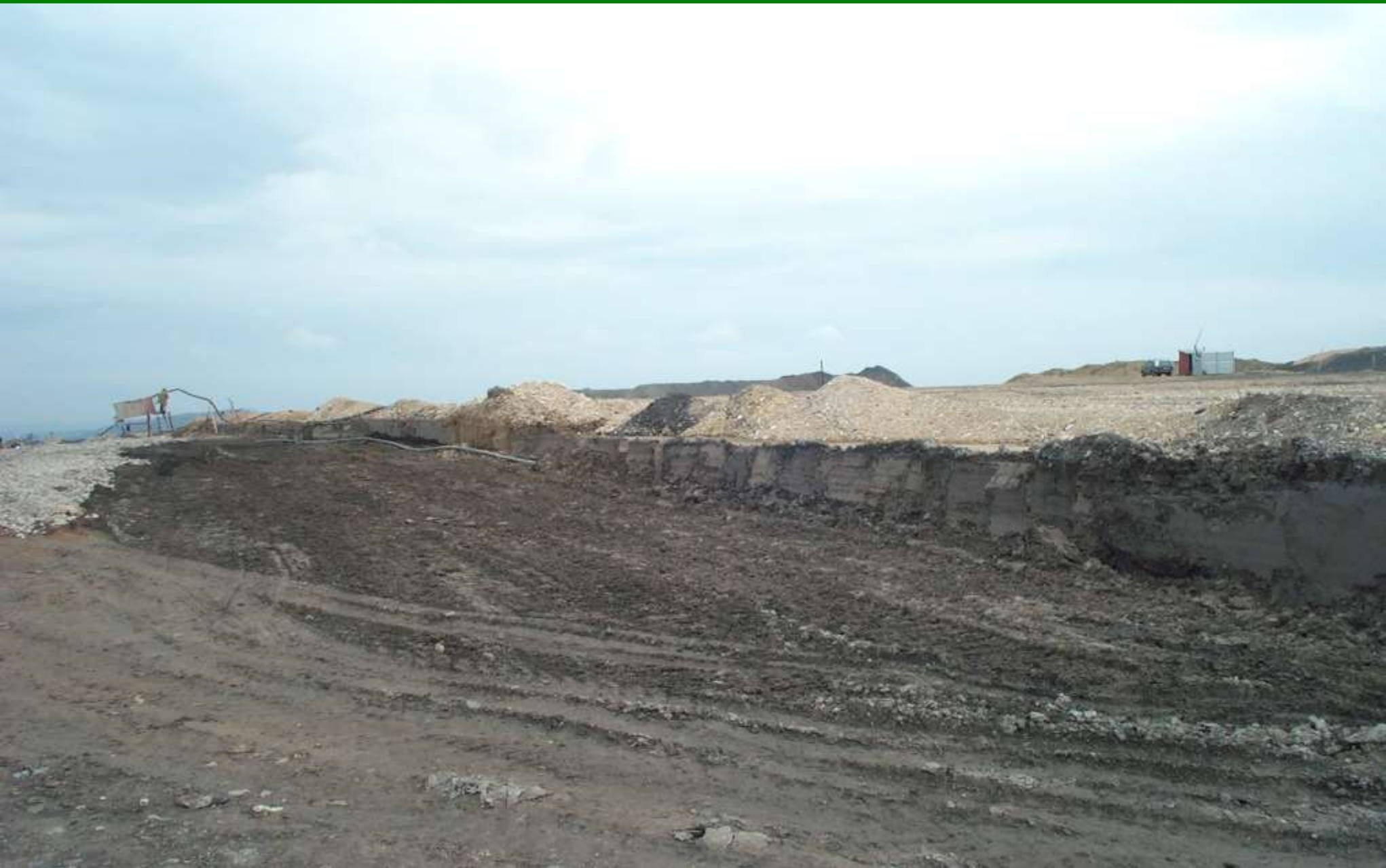
Mocnost korunové vrstvy sarkofágu
