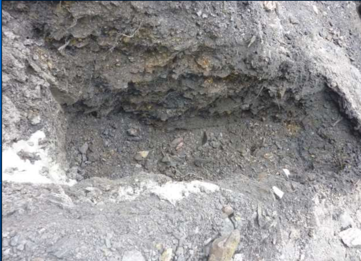
Výkop pro izolační stěnu
