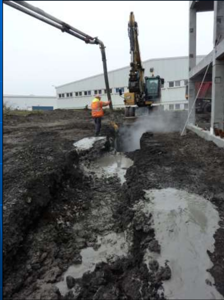
Dokončování izolační stěny kolem rohu nového objektu
