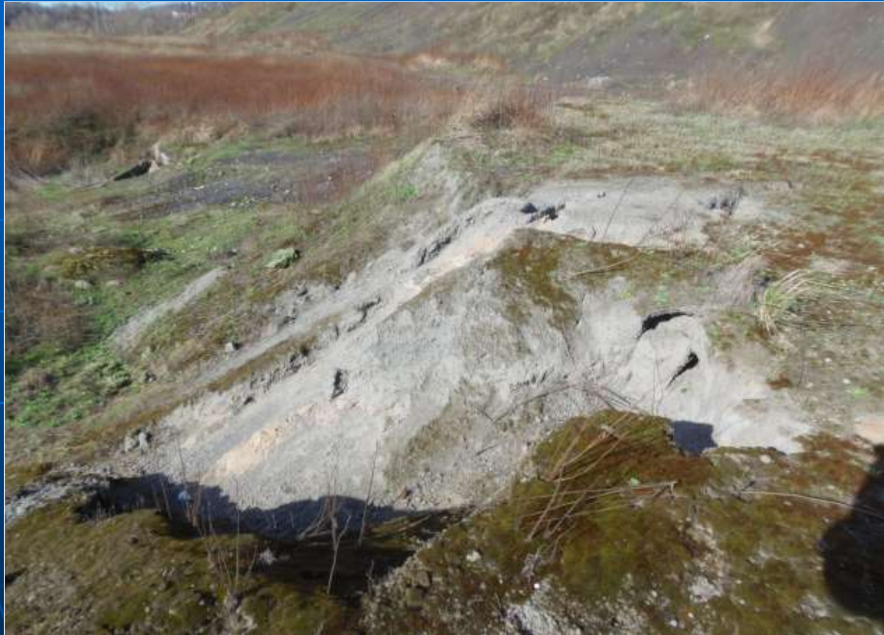
Těsnící vrstva elektrárenského popílku
