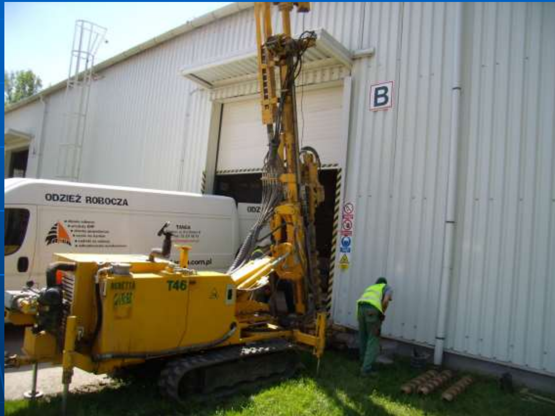
Vrtání pro injektážní sondy
