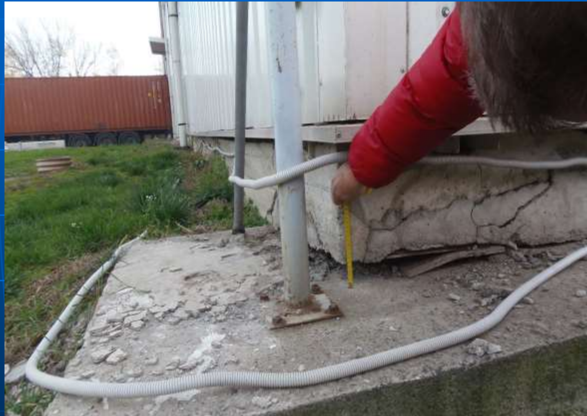
Pokles rohové patky skladovací haly
