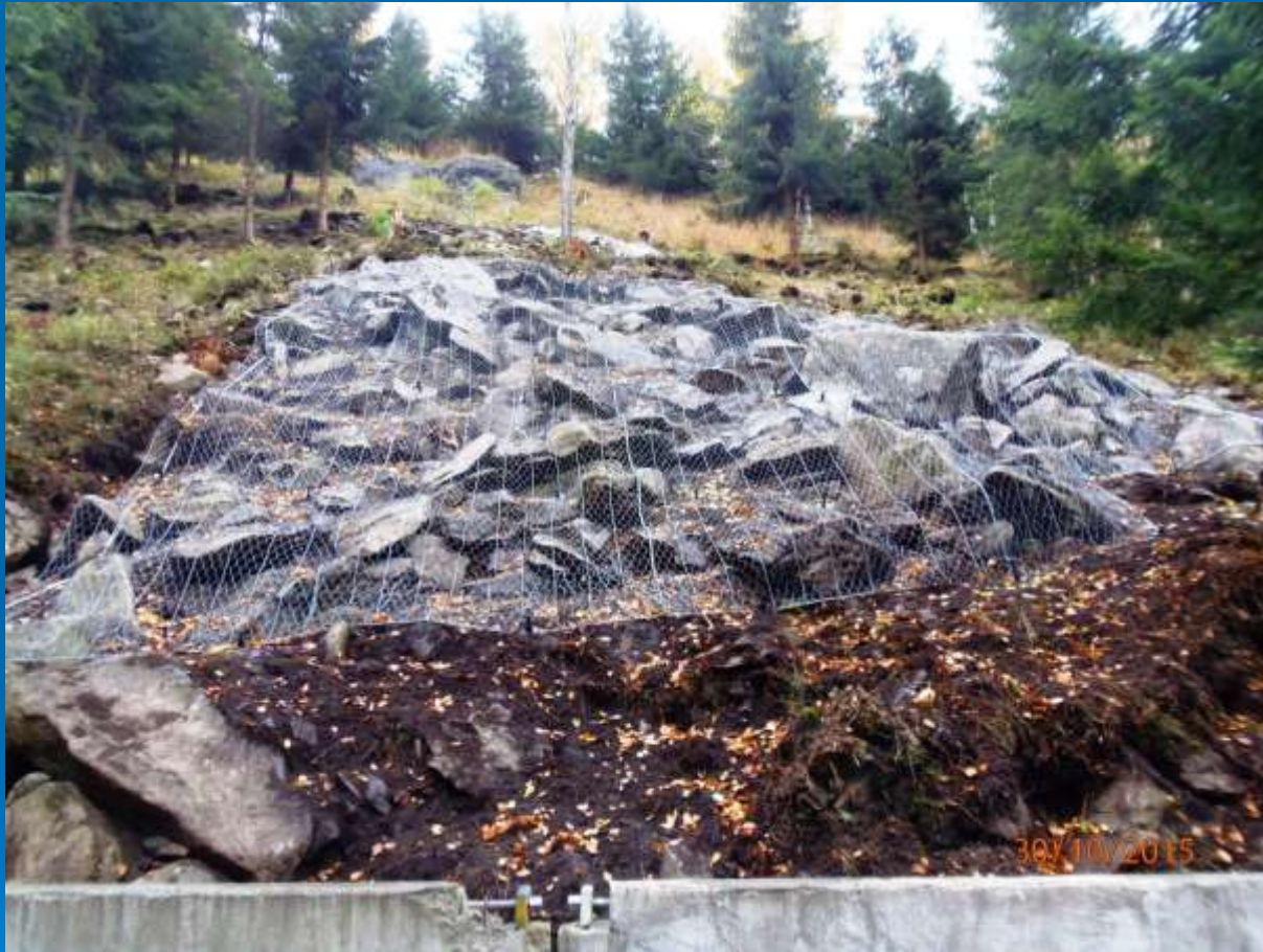
Zajištění svahu sítěmi
