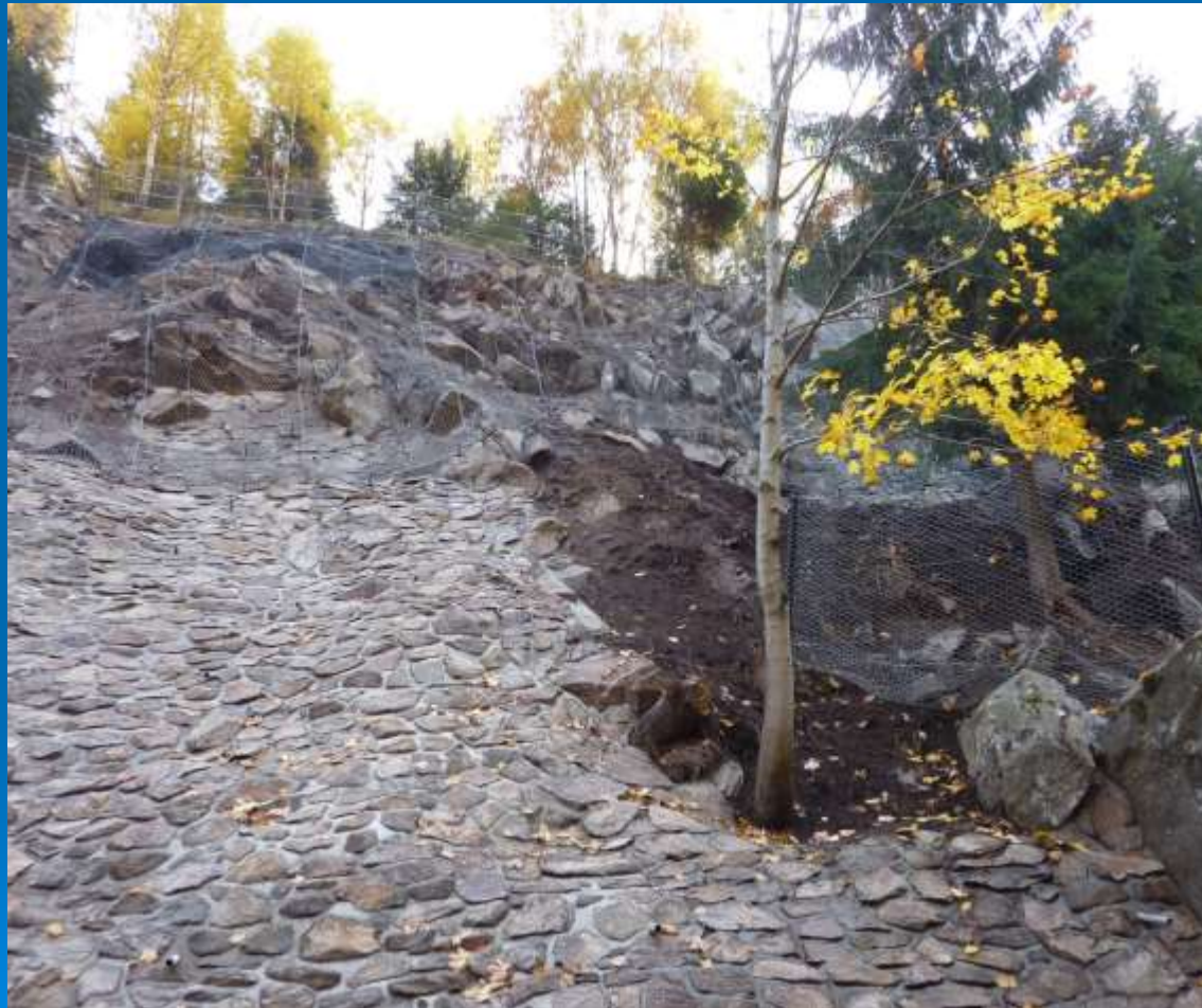
Ochranná kamenná konstrukce
