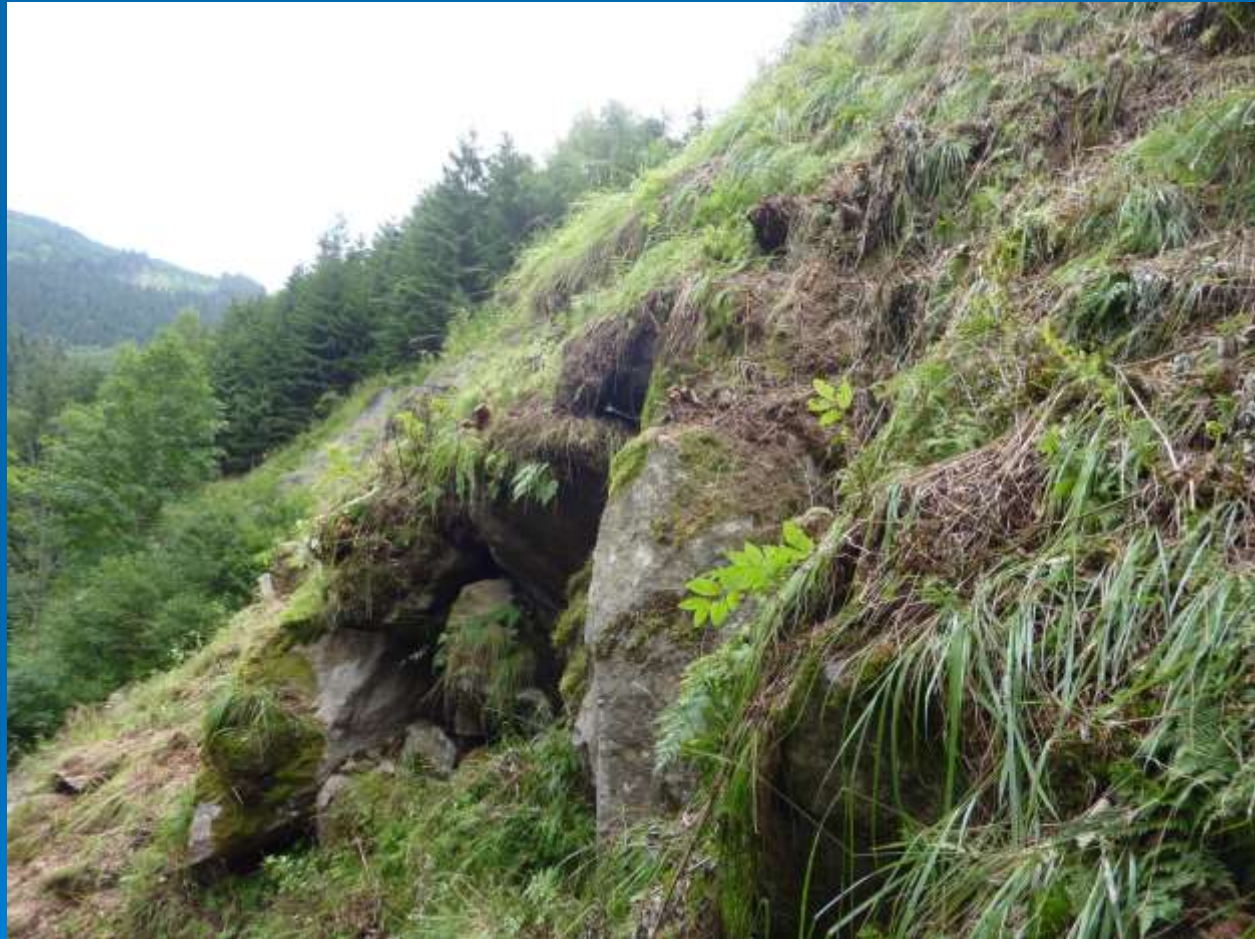
Vyčnívající porušené horninové bloky
