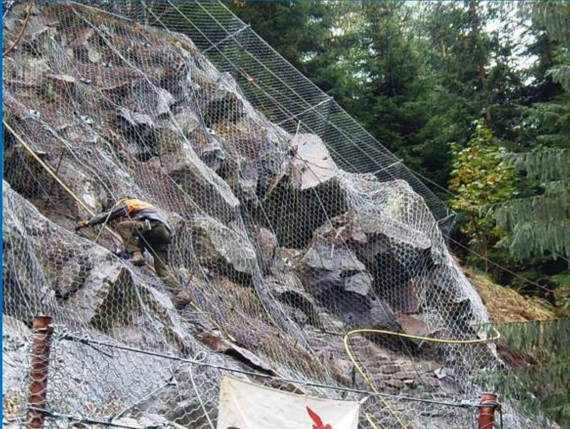
Ochranná konstrukce z ocelových sítí
