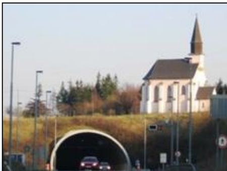
Tunel Hřebeč, silnice I/35 Svitavy – Moravská Třebová
