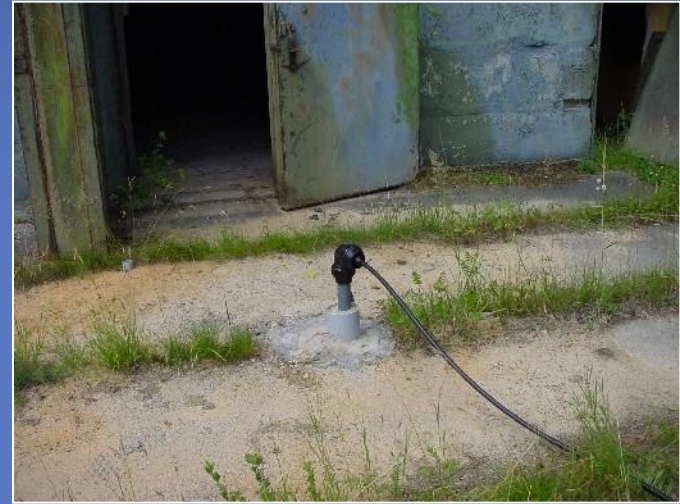
Obr. 8: Bioremediace: vrt pro zasakování živin
