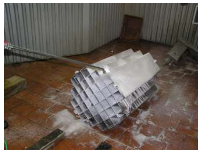
Pěnová dekontaminace
