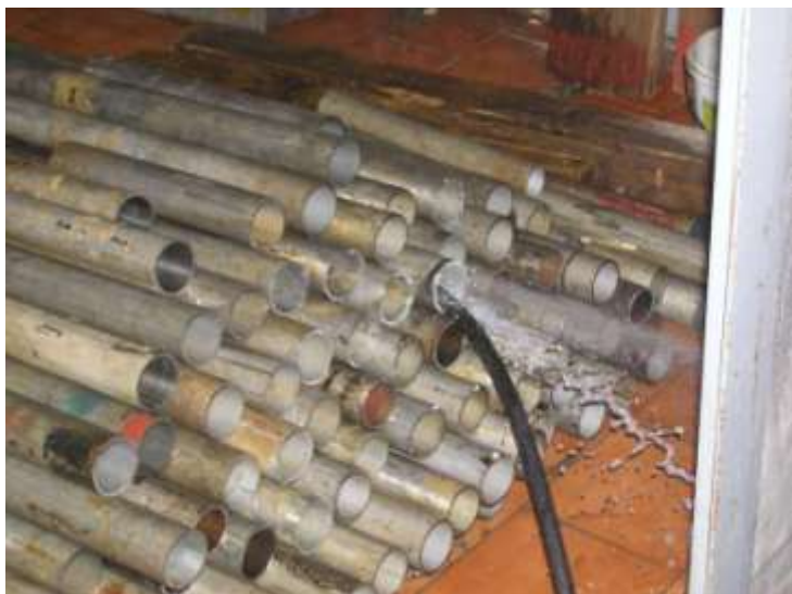
Dekontaminace trubek vysokotlakou vodou
