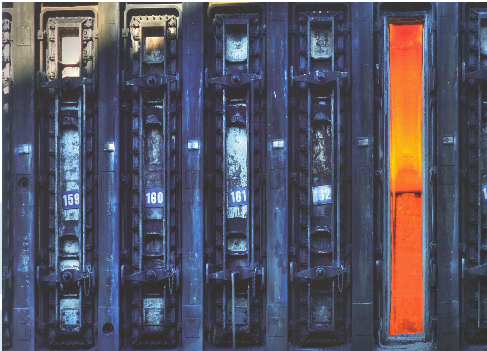
Pohled do koksovací komory
