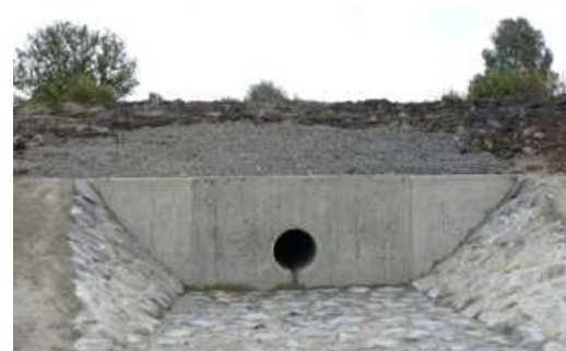
Vyústění větve „B“
