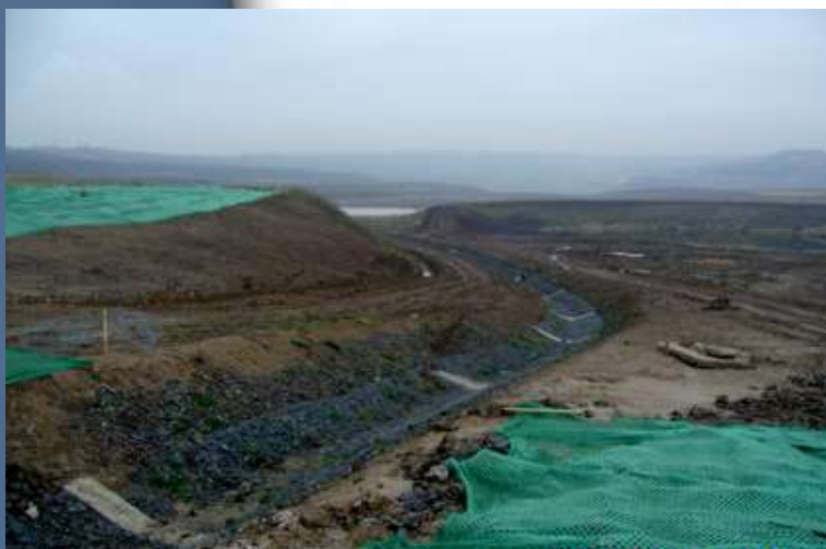
PŘÍVODNÍ KANÁL JIHOZÁPAD
