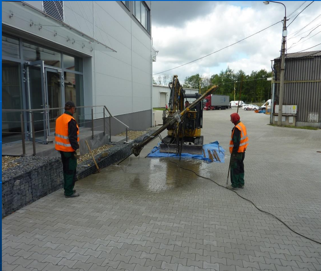
Obr. č. 4 Instalace injektážních sond pod základy stavby
