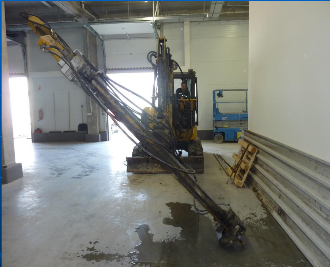
Obr. č. 5 Instalace injektážních sond pod podlahu
