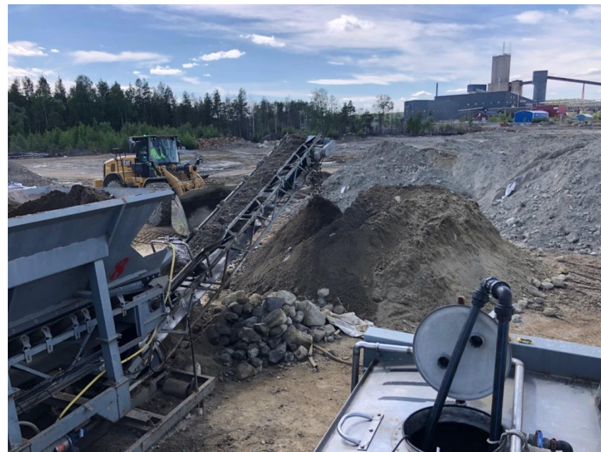
Obrázek 7 – Počáteční ošetření kontaminované zeminy, zapravení bakteriálního preparátu s makronutrienty
