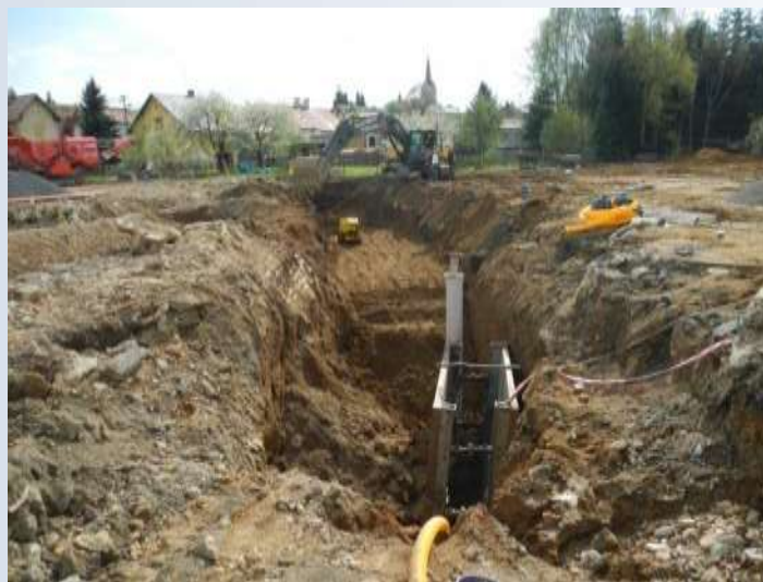
Sanace bývalého areálu KOVO Velká Hleďsebe
