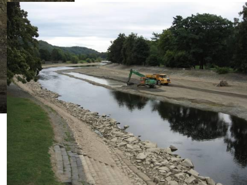
Úprava koryta, povodí Moravy
