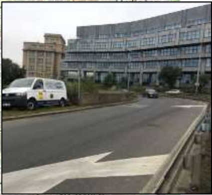
nájezd na Hlávkův most od nábr. Kapitána Jaroše ve směru do centra
