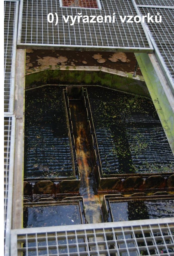
odtok z ČOV – 21.XI 2017 únik kalu z DN do odtoku
