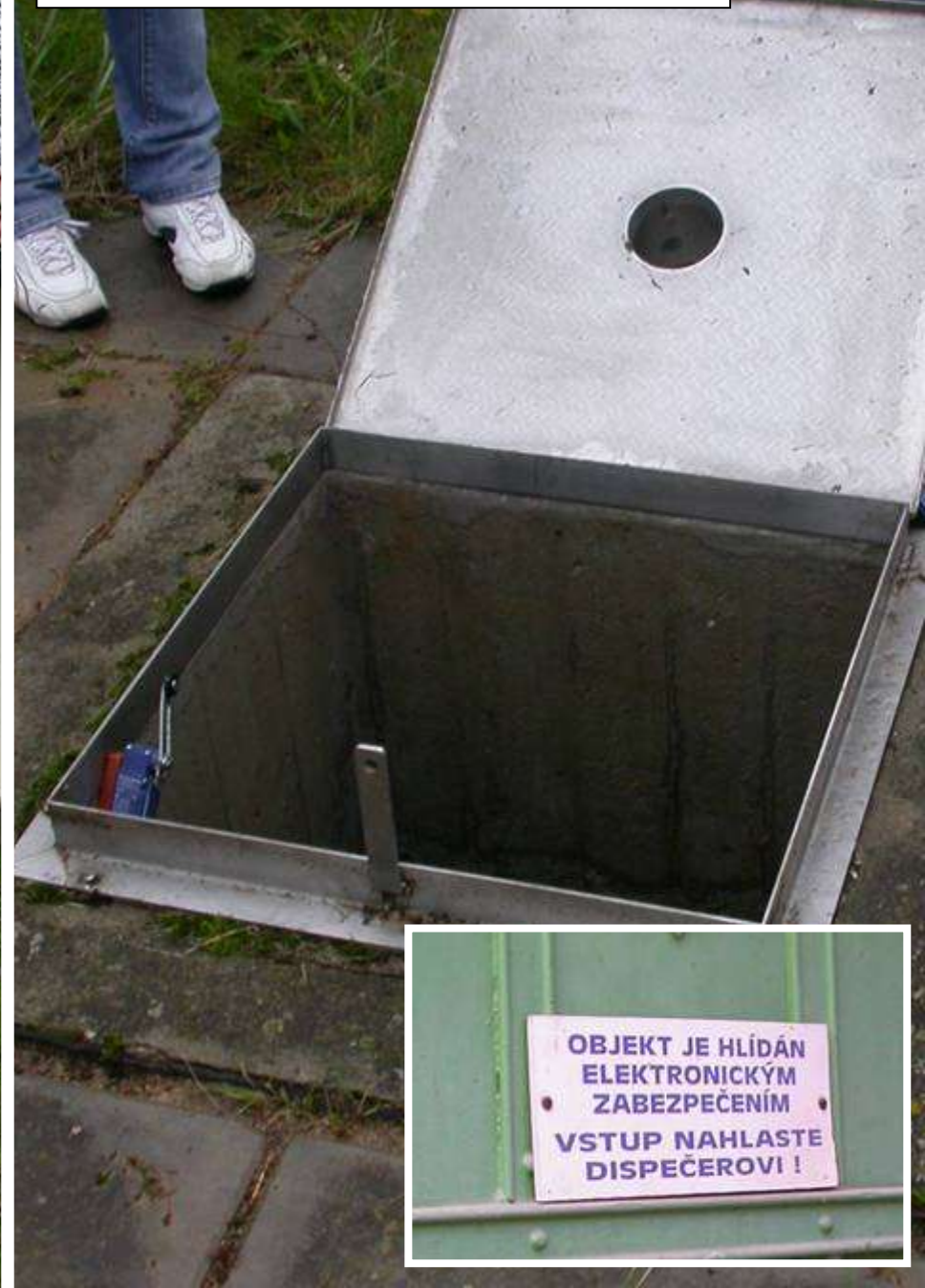
čidla hlásící otevření poklopů
