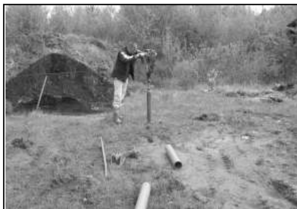
Obr. 1 Kaznějov: hloubení sondy S-1
