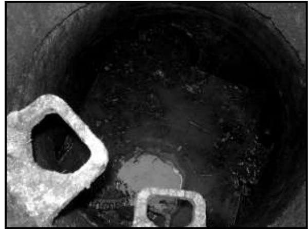
Obr. 2 Kanalizační šachta před čištěním
