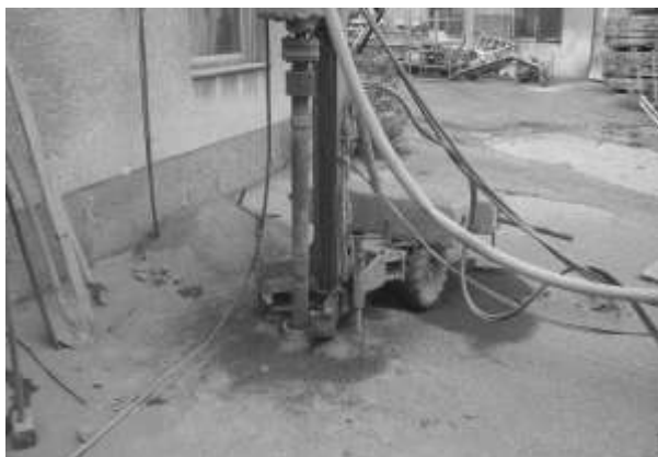
Obr. 5 Stříbro: Místo hloubení monitorovacího vrtu HJ-3 na západním okraji zpevněné plochy mezi skladem olejů a chemikálií a objektem “staré výroby“
