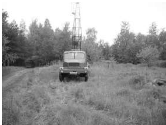
Obr. 8 Zruč-Senec: vrtné práce v prostorech bývalých kalových lagun
