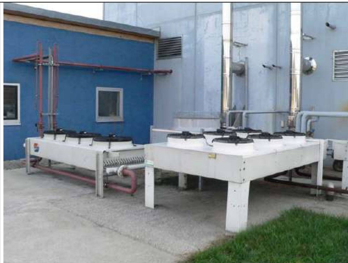
Obr. 8.4: Chladiče pro chlazení motoru kogenerační jednotky
