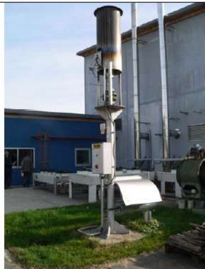
Obr. 8.3: Bezpečnostní plynový hořák
