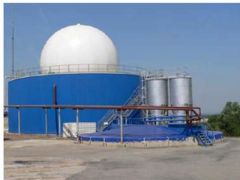
Obr. 8.2: Textilní dvouplášťový plynojem fy SATTLER (Rakousko) (objem 100 – 2150 m 3 , polyesterová tkanina + PVC, nízkotlaký 0,5 – 2,5 kPa, životnost 20 – 30 let) – firmu SATTLER zastupuje v ČR K & H Kinetic a.s.
