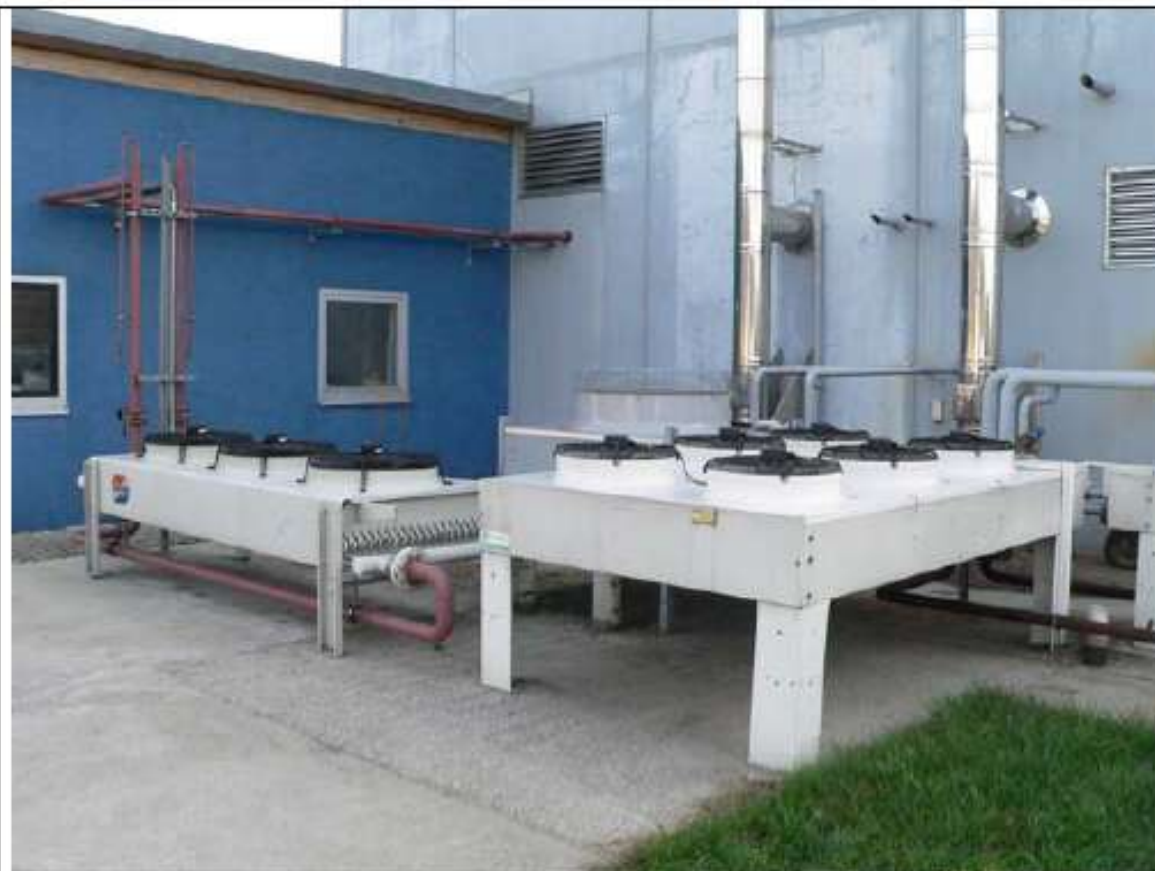
Obr. 8.4: Chladiče pro chlazení motoru kogenerační jednotky
