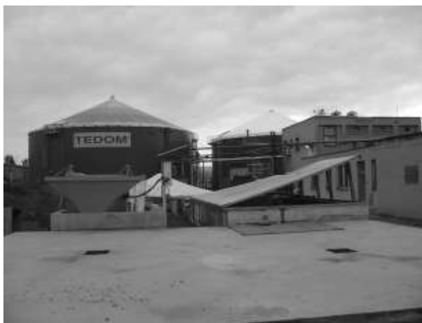
Obr. 3: Textilní dvouplášťový nasedlaný plynojem, obvykle polyesterová tkanina + PVC, nízkotlaký 0,5 – 2,5 kPa, životnost 20 – 30 let nabízí řada firem, v ČR např. Tomášek SERVIS s.r.o.
