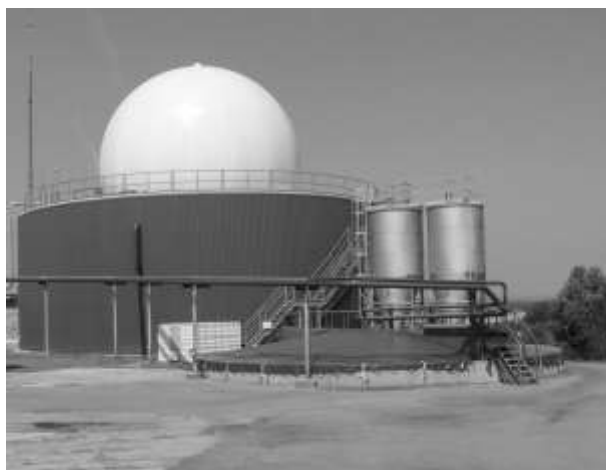
Obr. 4: Textilní dvouplášťový plynojem fy SATTLER (Rakousko) (objem 100 – 2150 m 3 , polyesterová tkanina + PVC, nízkotlaký 0,5 – 2,5 kPa, životnost 20 – 30 let) – firmu SATTLER zastupuje v ČR K & H Kinetic a.s.
