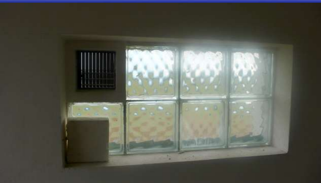
Okenní otvor zazděný luxfery a žaluzií
