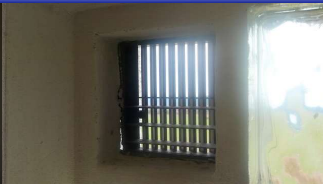
Okenní otvor zazděný luxfery a žaluzií
