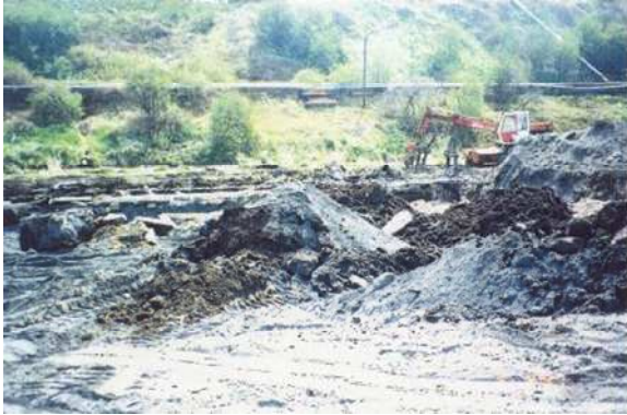
Materiál kontaminované vrstvy – zemina, popel, betonové panely, sudy s oleji a samozřejmě dehet
