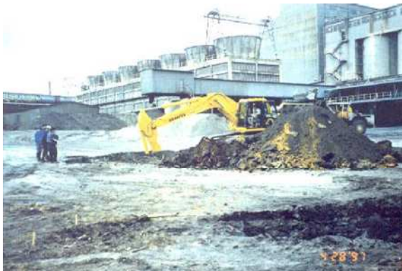
Začátek sanačních prací – hloubení průzkumného výkopu v místě budoucí kotelny a zákotlí
