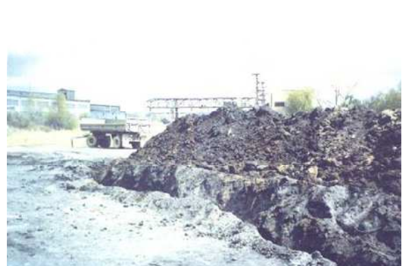
Začátek sanace – hloubení průzkumného výkopu
