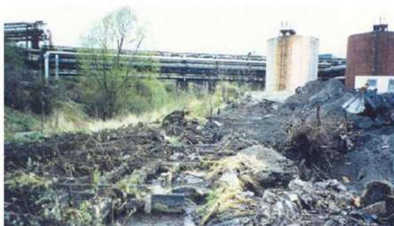
Betonová nádrž na separaci dehtu po odstranění vegetace a navezení odpadu před zahájením demolice
