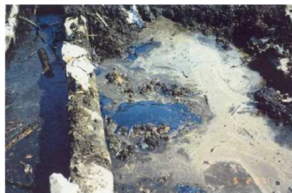
Detail likvidované betonové nádrže obsahující dehet
