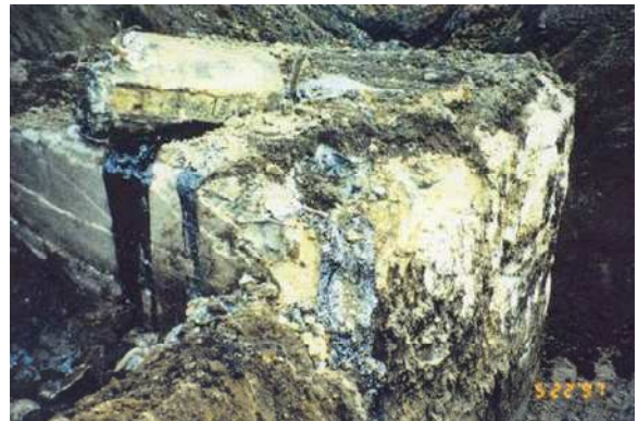
Ukončení těžby kontaminovaných vrstev až na původní geologické vrstvy, někde až cca 5 až 8 metrů
