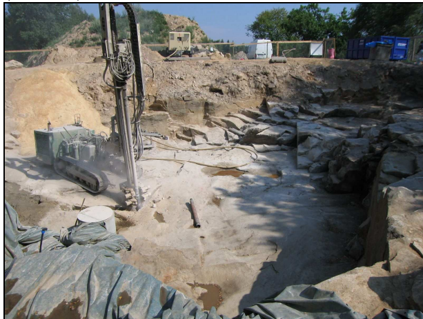
Lom po vytěžené skládce – vrtné práce ve dně (09/2007)
