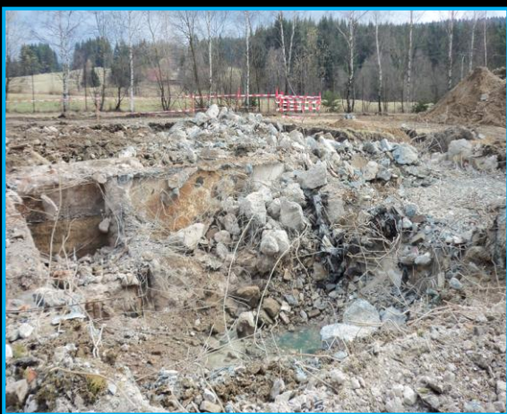
Po demolici nadzemních konstrukcí
