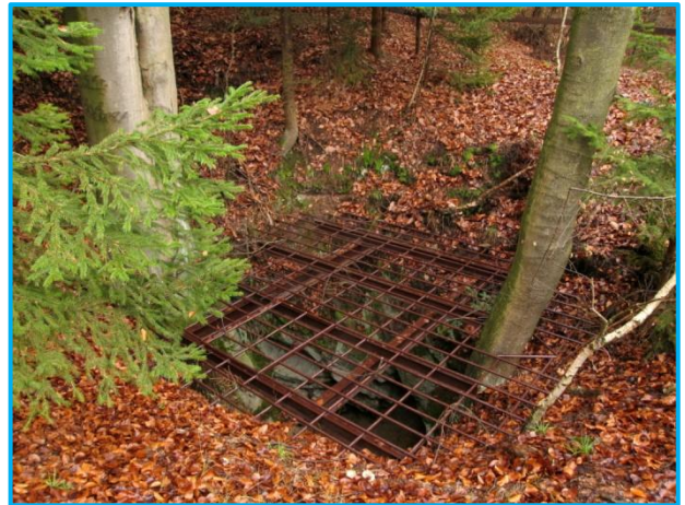
Horní Čepí - šachta pod lesní cestou - stav před a po zajištění
