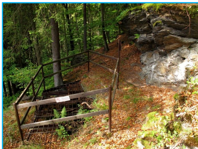
Šachta Cumberk před a po zajištění
