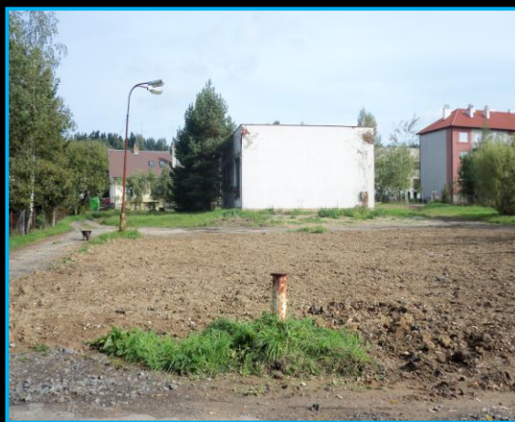
Rekultivace po provedených demol. a sanač. pracích
