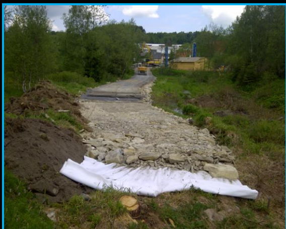
Příprava staveništní komunikace
