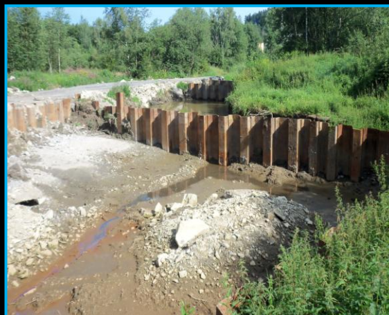
Výkopy vymezené štětovými stěnami
