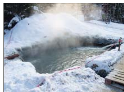
Výplachové hospodářství vrtné soupravy při -20 °C
