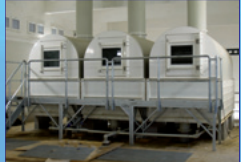
Horizontální provzdušňovač vody HPV
