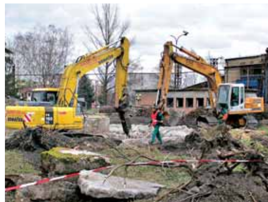
Demolice objektů bývalého olejového hospodářství v areálu pomocného závodu
