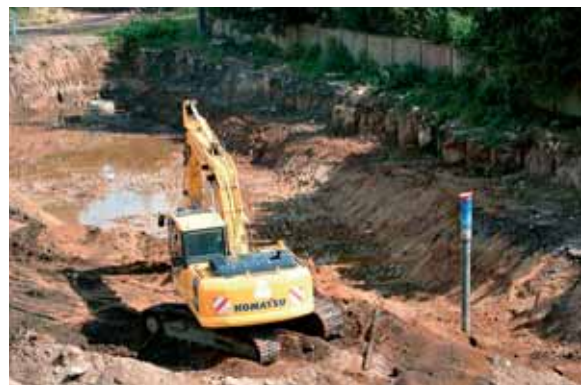
Odtěžení zeminy v ohnisku „Bývalá plynárna“ (kontaminace dehty a ropnými látkami)
