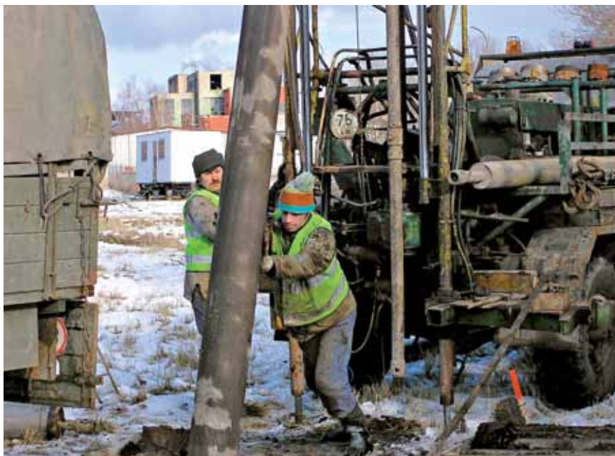
Hloubení vrtů pro monitoring a sanační čerpání podzemní vody
