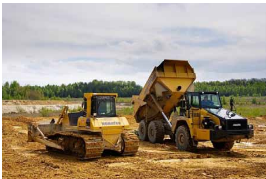
Obrázek č. 5: Ukládání neutralizačních kalů na odkaliště
