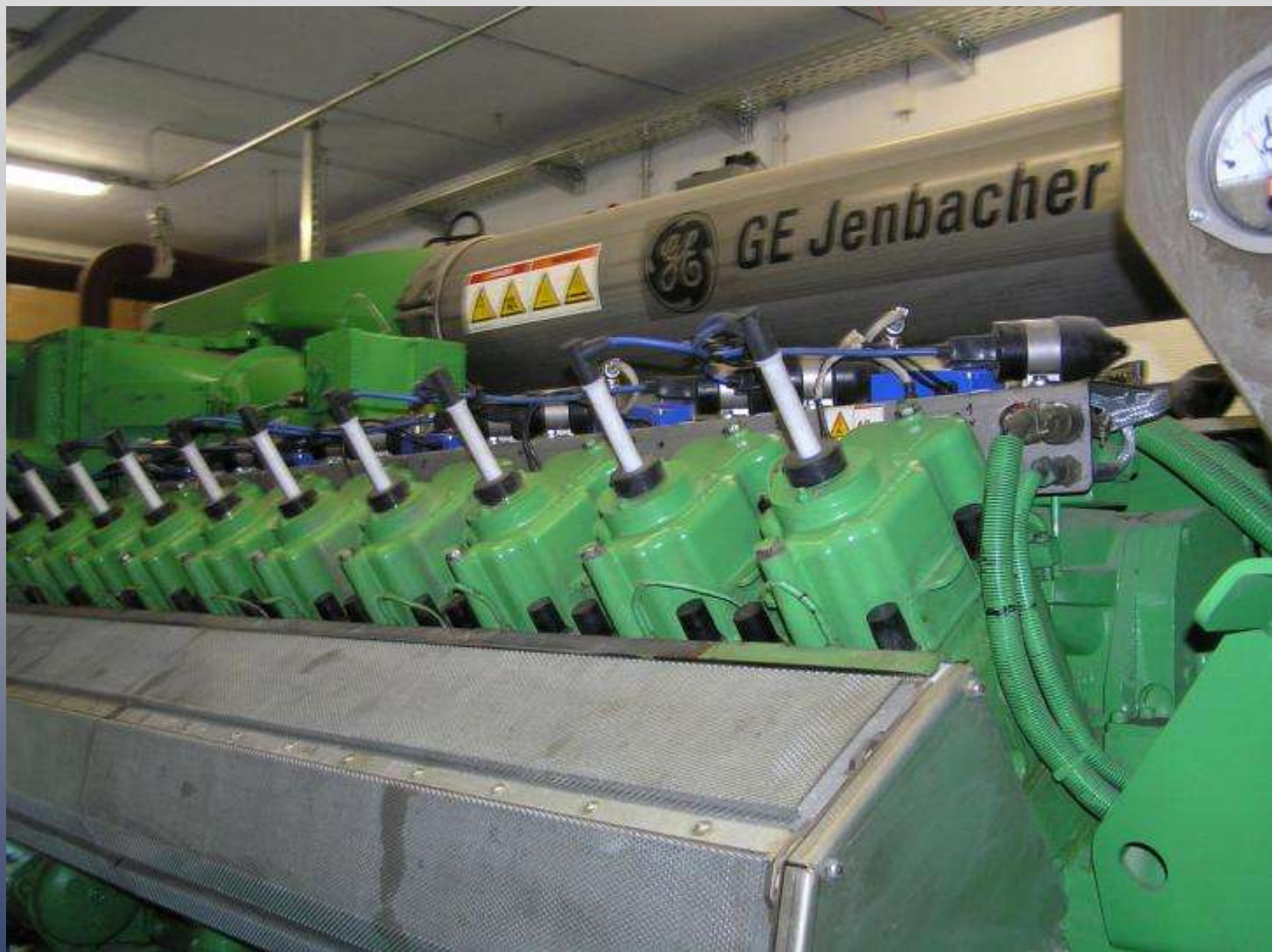
Plynový motor kogenerační jednotky
