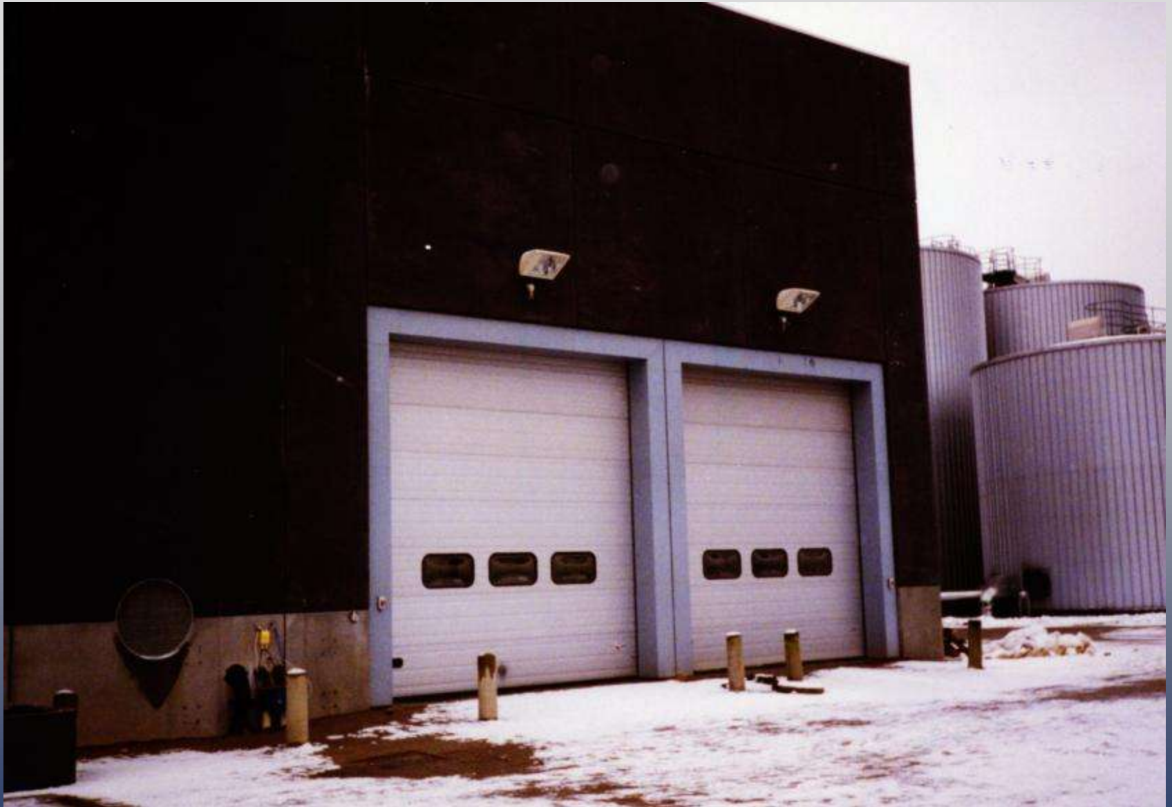
Stanice na odděleně sbíraný bioodpad - Dánsko
