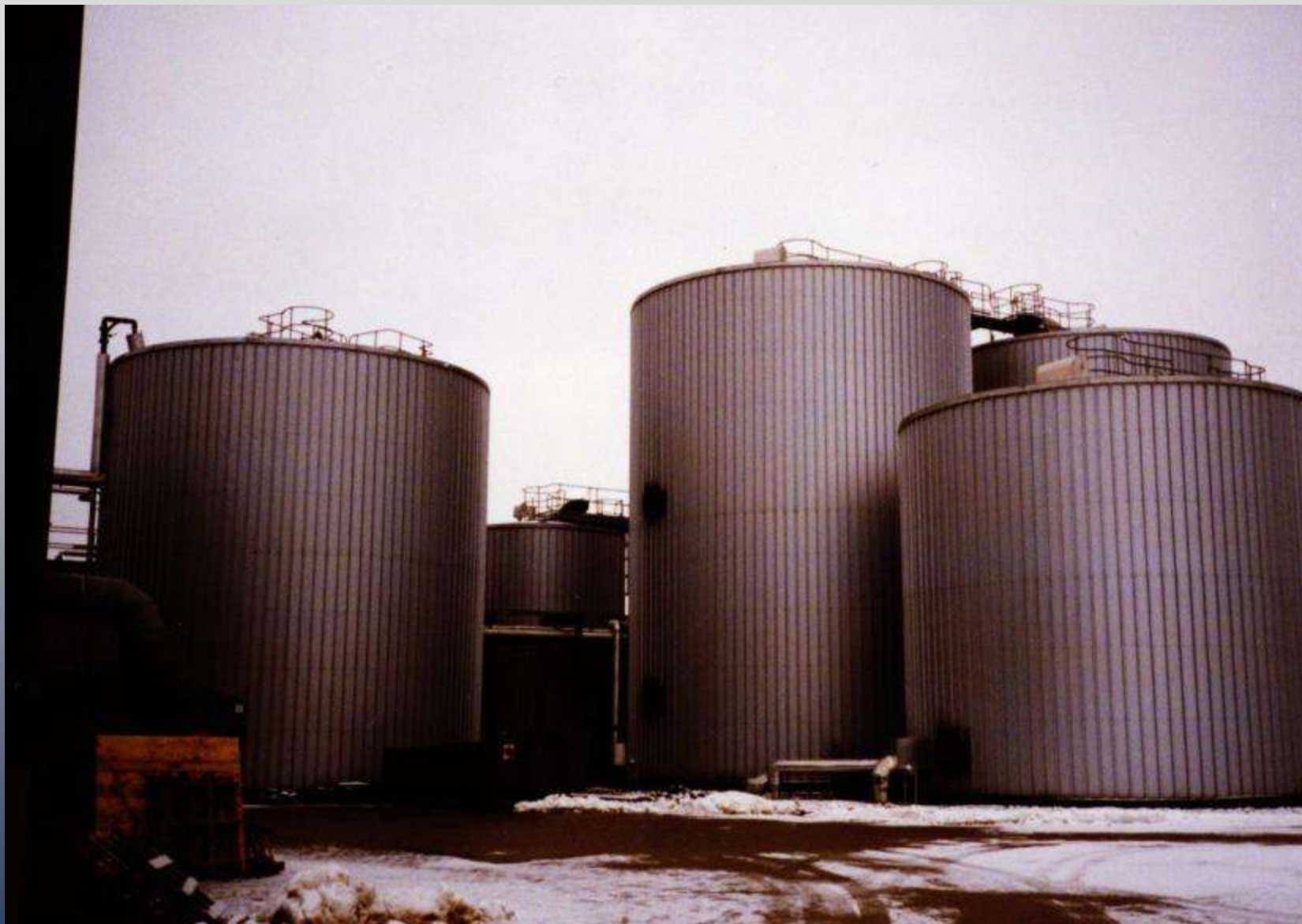
Stanice na odděleně sbíraný bioodpad - Dánsko
