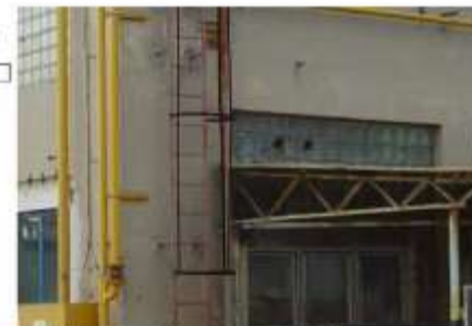
Popis obrázku 1: Pohľad na jednu z budov starej hlavnej výroby teplej vody a sklad chemickej
