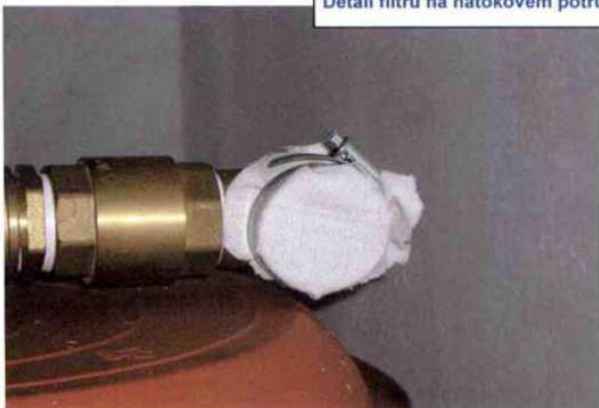
Detail filtrů na nátokovém potrubí vodojemu.
