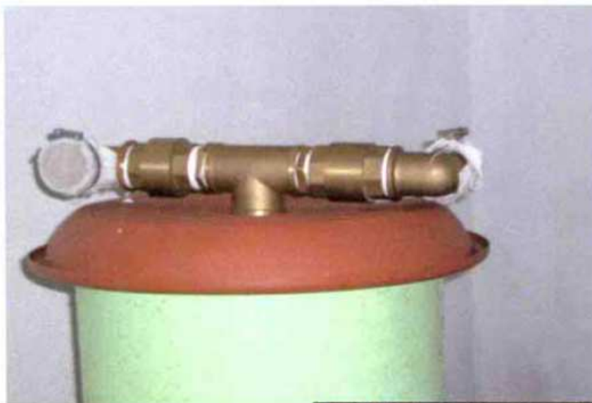
Detail filtrů na nátokovém potrubí vodojemu.
