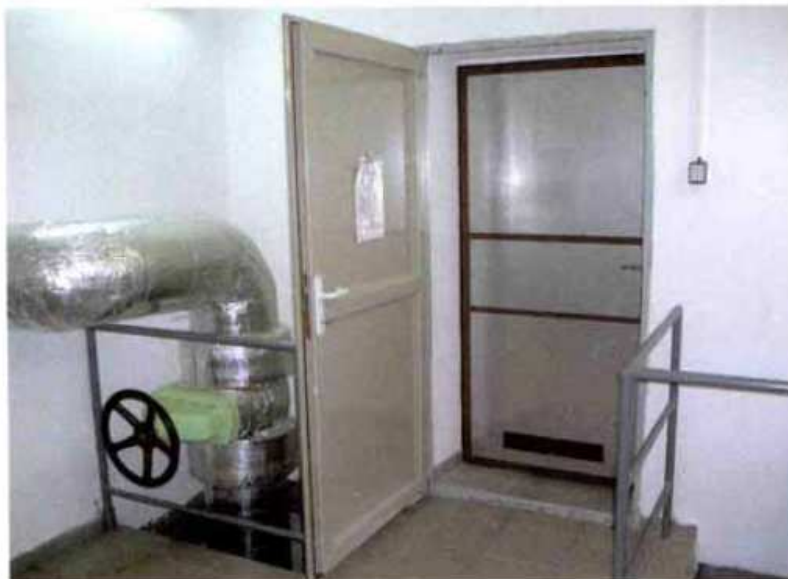
Výměna vstupních dveří do armaturní komory vodojemu
