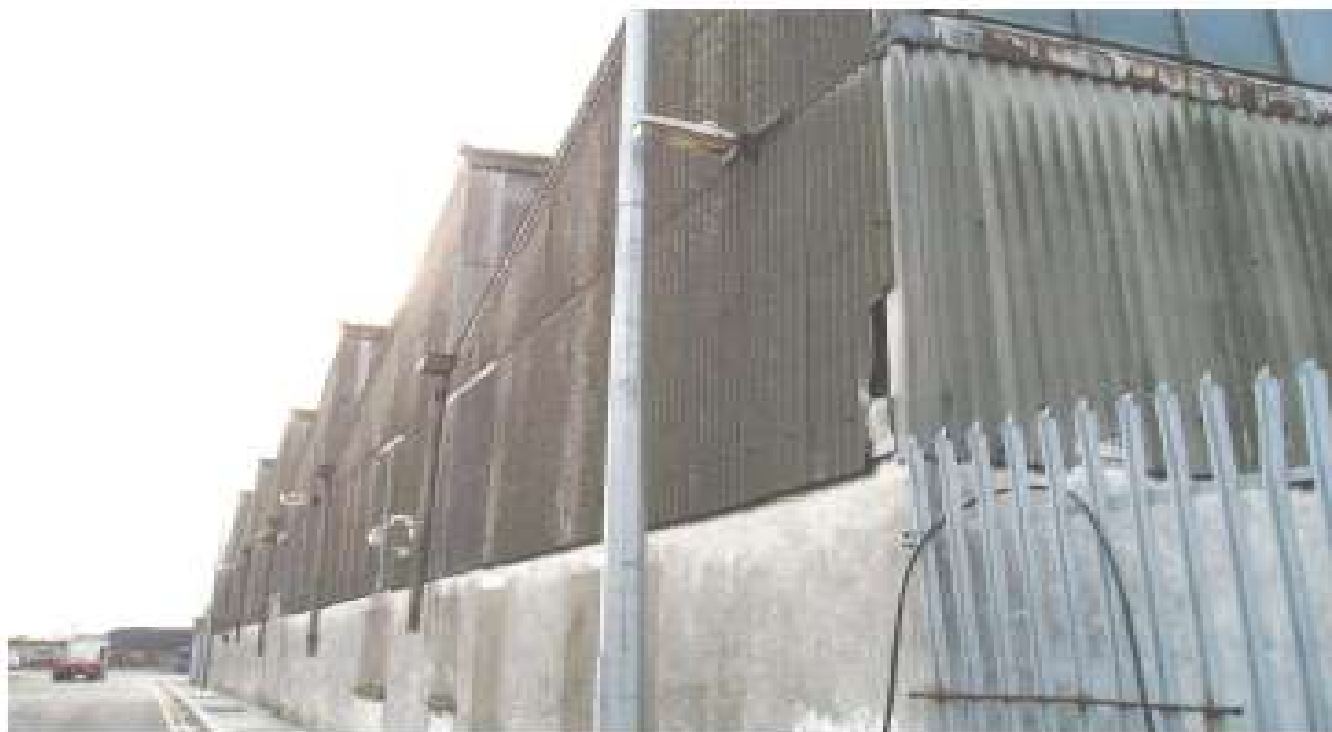
Obrázek 4.10: Azbestocementový plášť tovární zdi.
