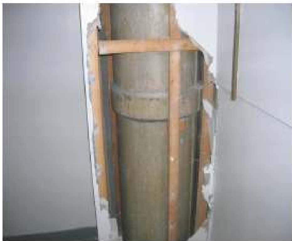
Obrázek 4.2: Azbestocementová kouřová trubka, která je vidět pod částečně odstraněným pláštěm z azbestové izolační desky
