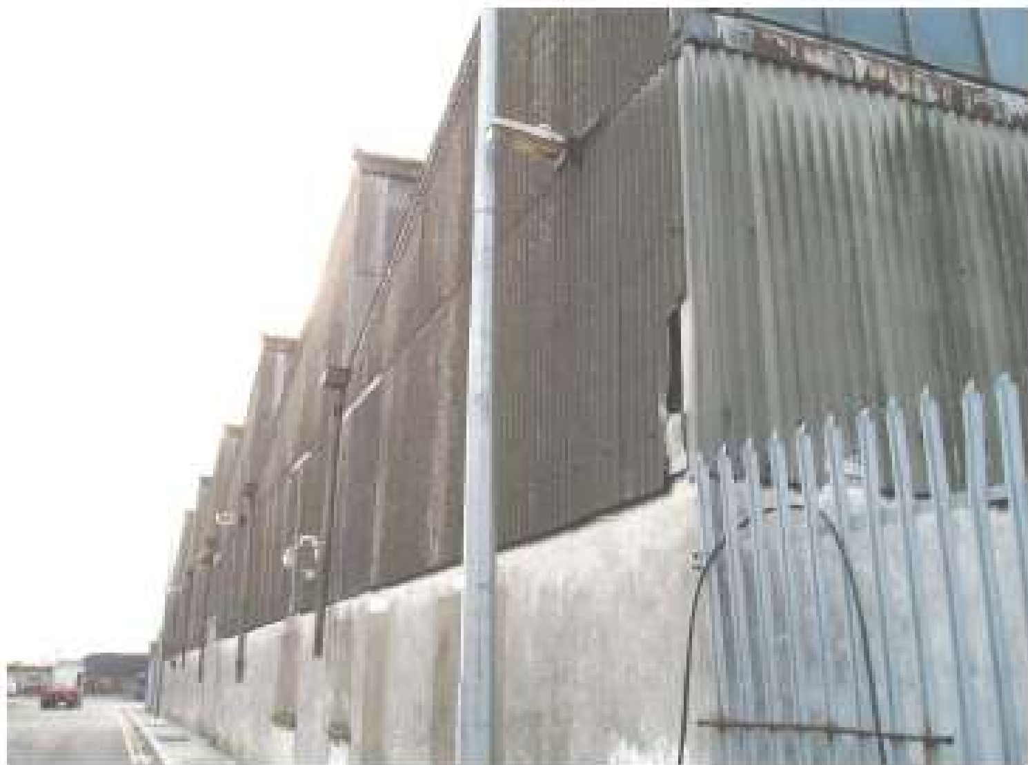
Obrázek 4.10: Azbestocementový plášť tovární zdi.
