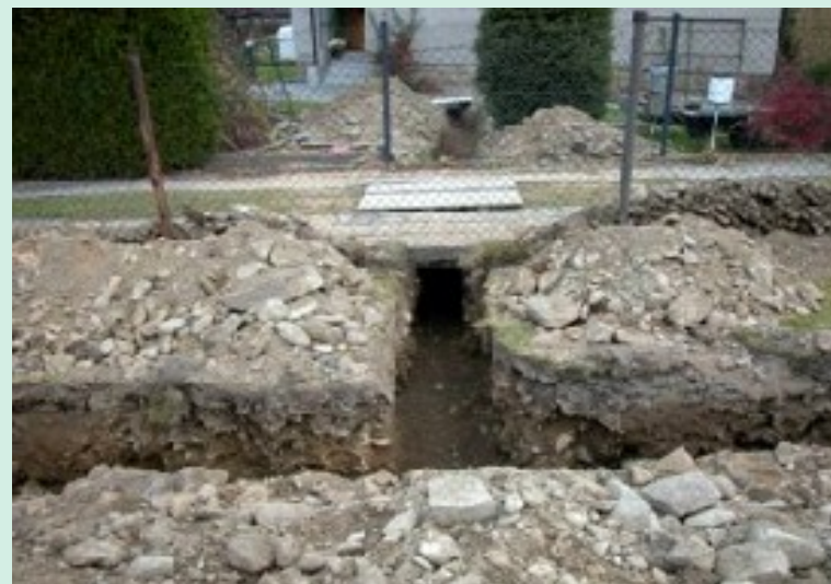
3 km rozvodů, 65 předávacích stanic
