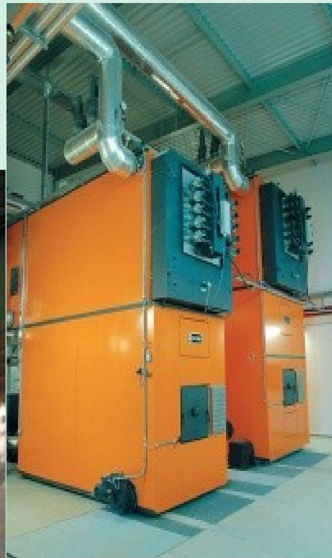
Kotle Schmid 2,4 MW a 1,6 MW
