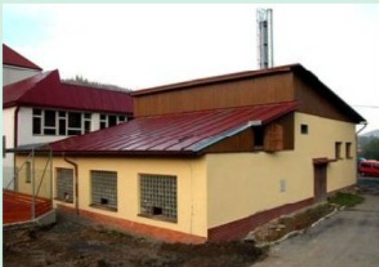
Kotelna 1,5 MW (0,9 MW a 0,6 MW – palivo piliny)
